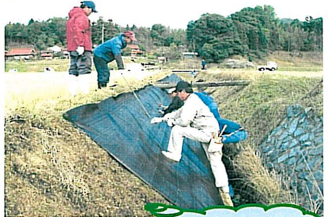
敷設の状況です
