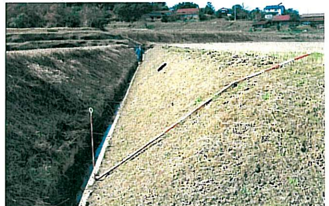
法面整地完了
